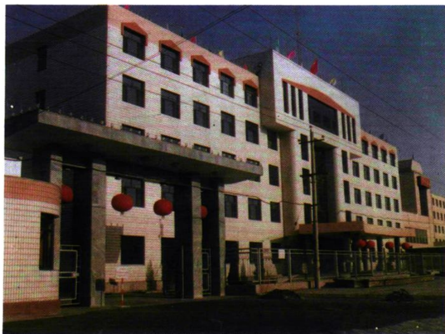
内蒙古自治区税务局办公大楼
