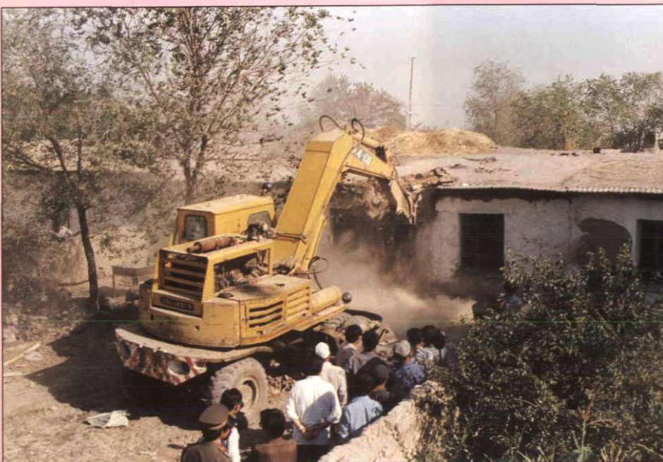
米泉县土地管理局对非法占用土地修建的房屋依法强行拆除
