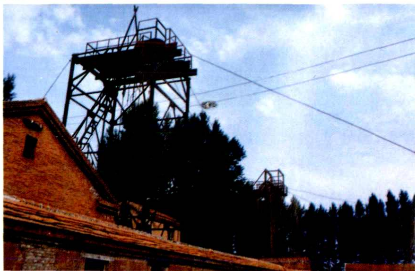
“二五”期间建设的 蛟河煤矿奶子山立井
