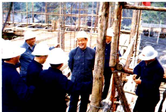
东煤公司副经理韩英在通化矿 务局湾沟矸石电厂建设工地视察 （1987年）
