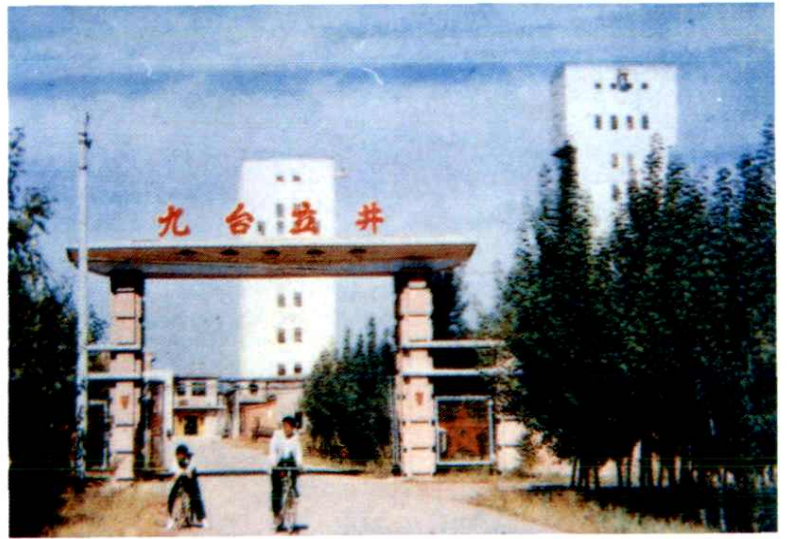
“五五”期间建设的 舒兰矿务局营城煤矿九 台立井
