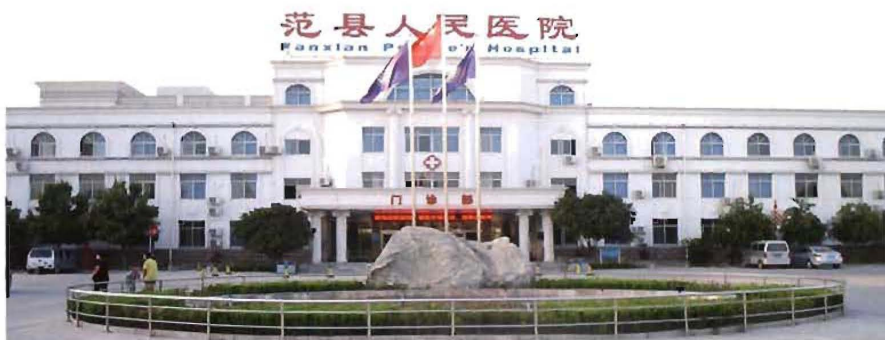
宽敞 靓丽 整洁的范县人民医院门诊楼
