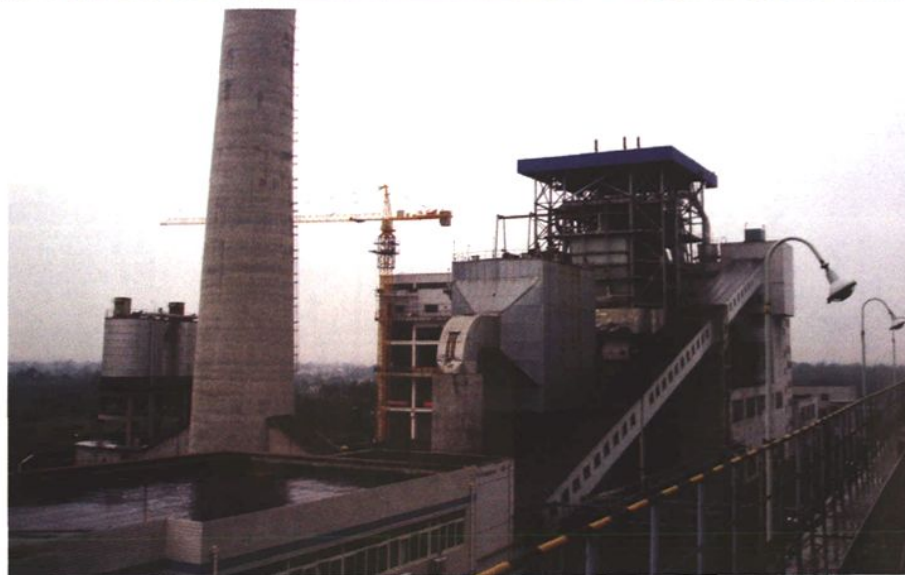
淮南化工 集团热电站
