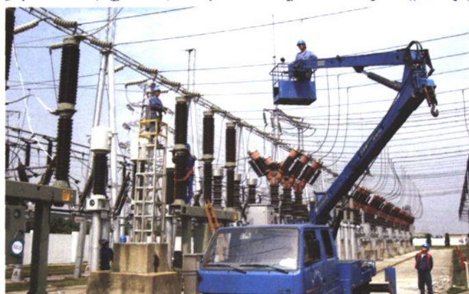
淮南供电公司职工在220千伏金家岭变电所进行设备检修
