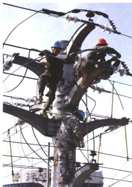
淮南供电公司职工在配电线路上作业
