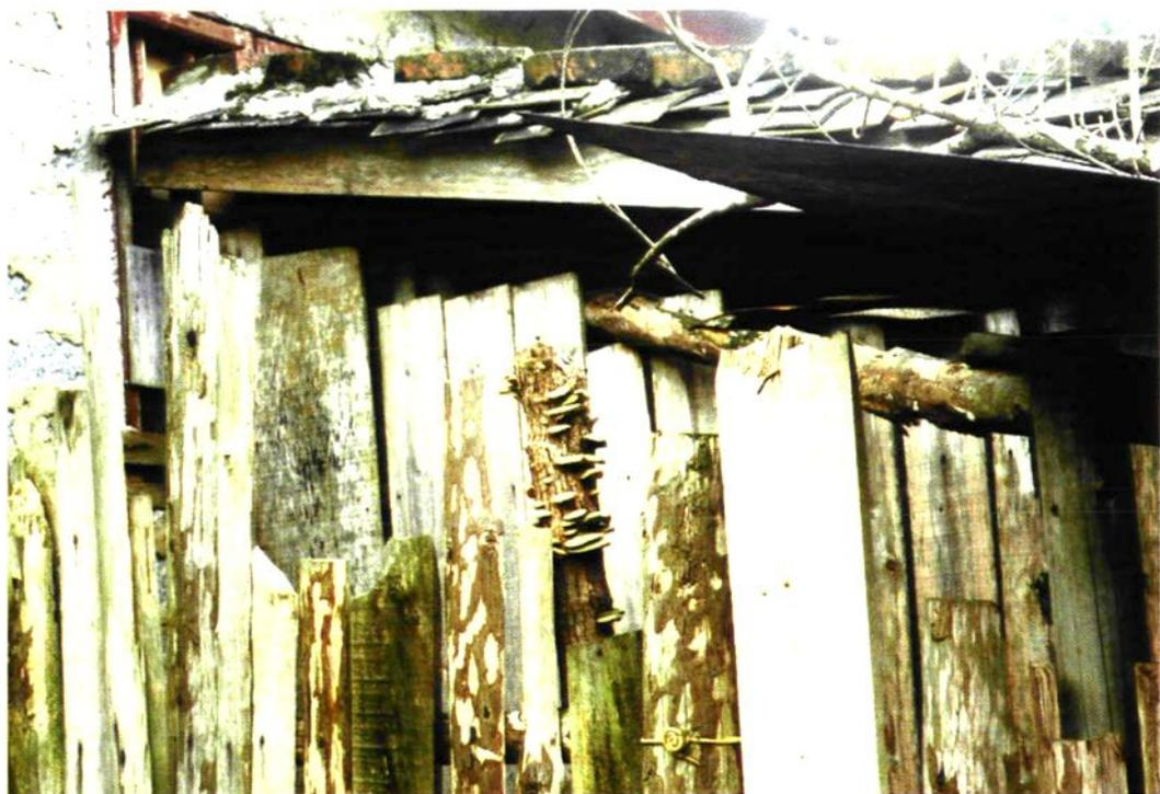
图 VIII 木质建筑上的腐朽菌
