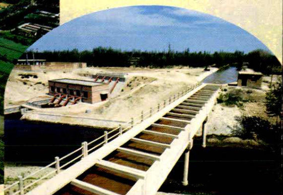
主体引水工程
