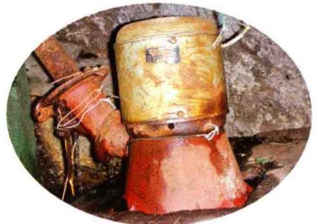
1 千瓦微型水轮发电机组
