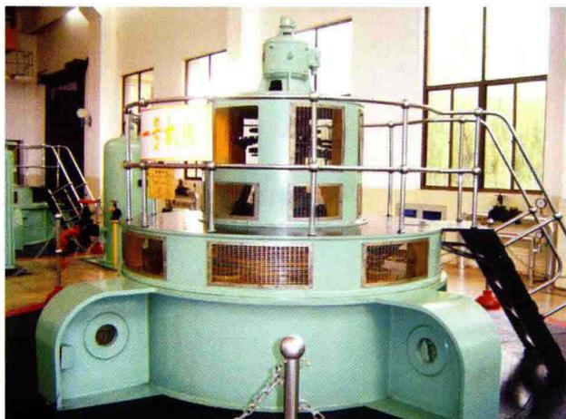
枫树岭水电站立式水轮发电机组
