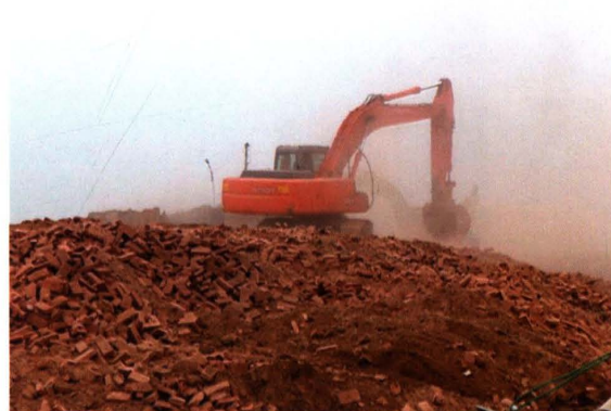
砖瓦窑拆除现场
