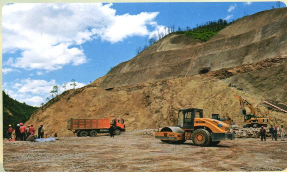
梨地坪水库建设
