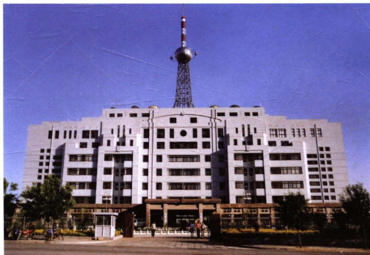
广播电视大楼
