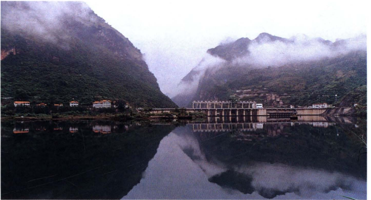
天生桥二级水电站首部枢纽
