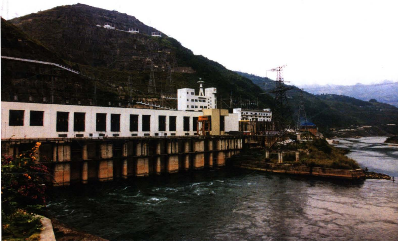
天生桥二级水电站发电厂房
