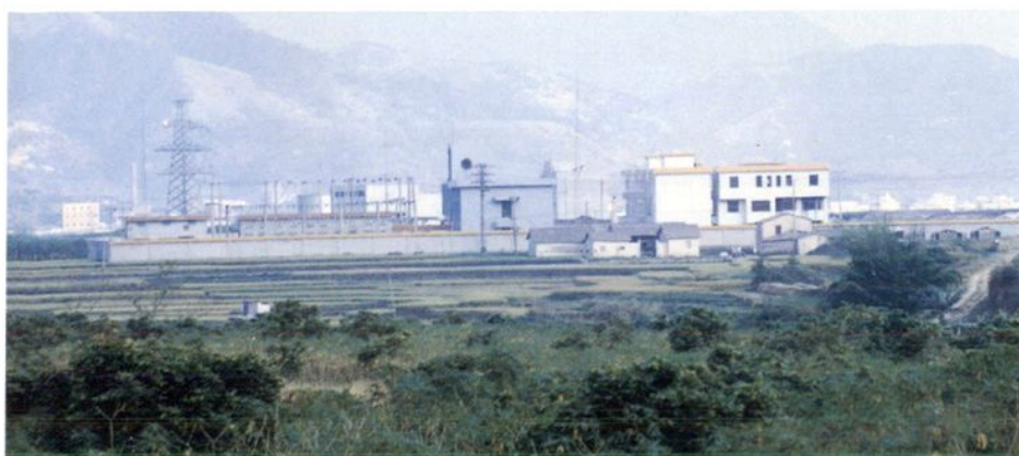
110千伏汤坑变电站
