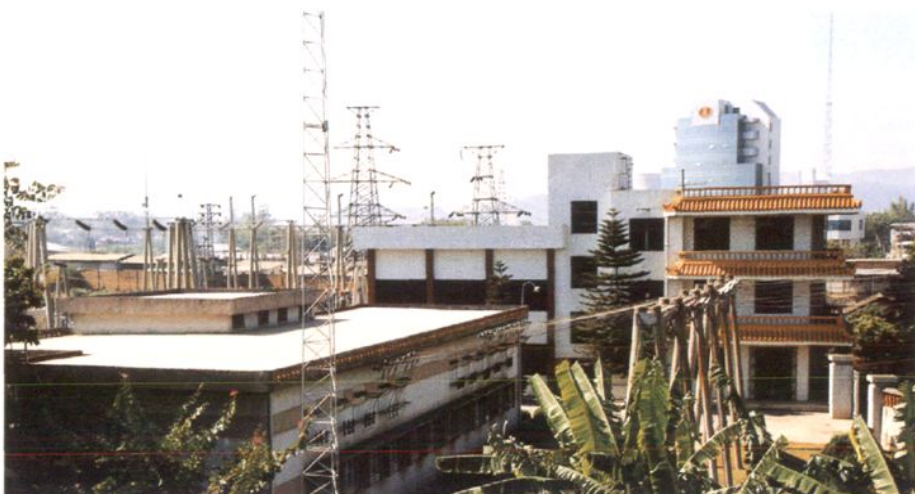
110千伏西区变电站
