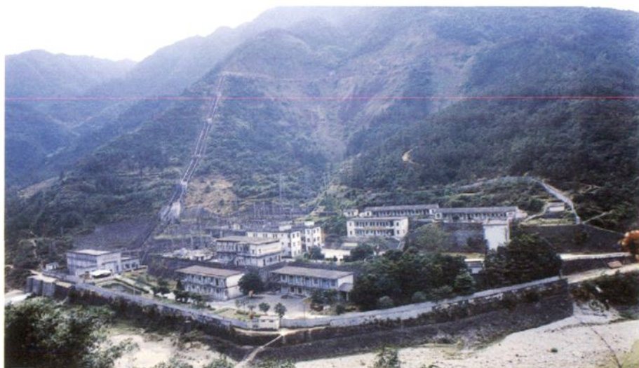
丰顺县八乡二级水电站
