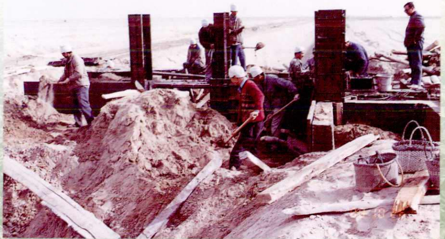
兴建水工建筑 (1998)
