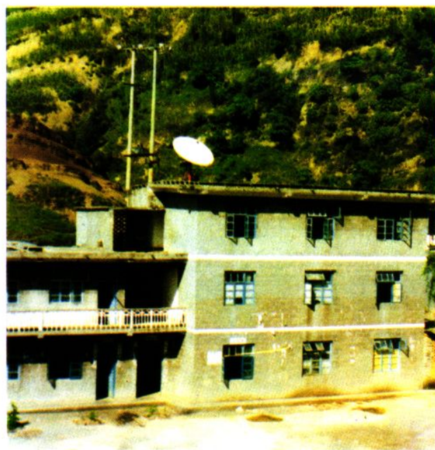
沙底沟电站副厂房
