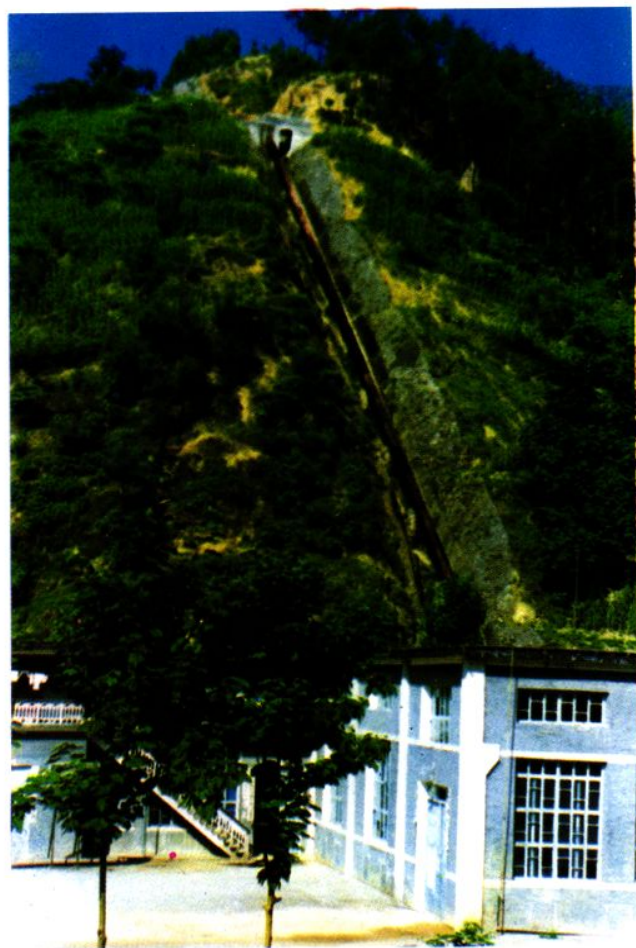
1986年6月沙底沟电站送电,现装机 2 \times 630 千瓦
