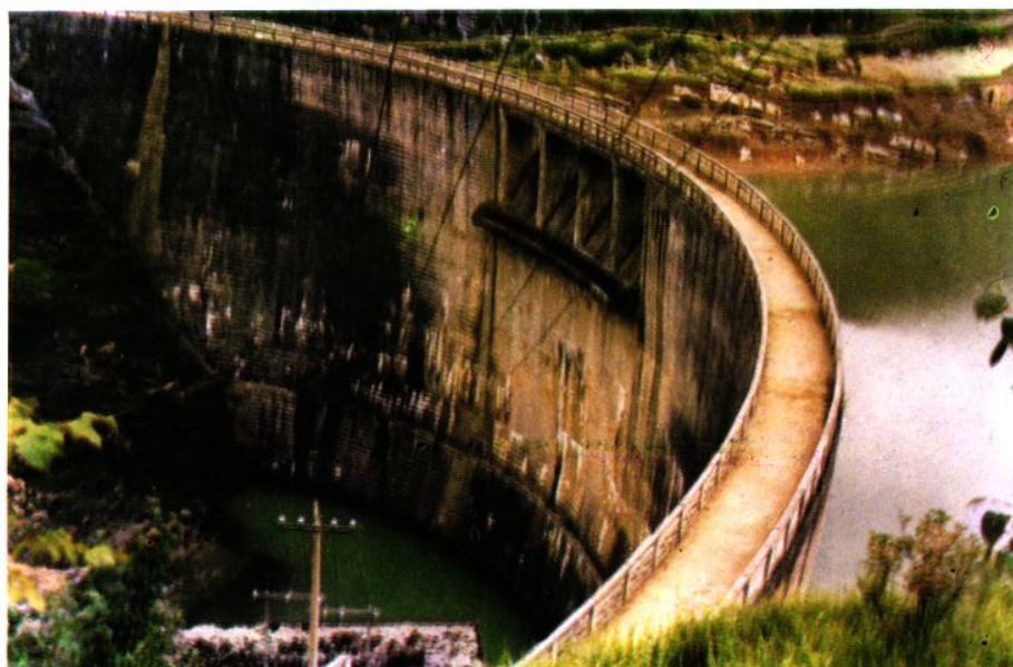
官舟水库浆砌石双曲拱坝(坝高46米)
