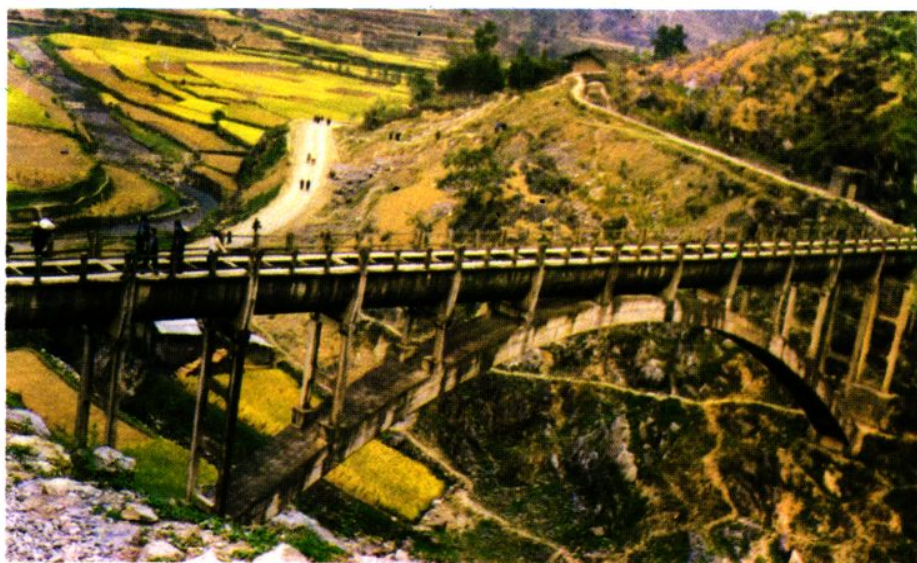
韩井沟钢筋混凝土「U」型薄壳渡槽 ( L=73.5M^3Q=5M^3/s )
