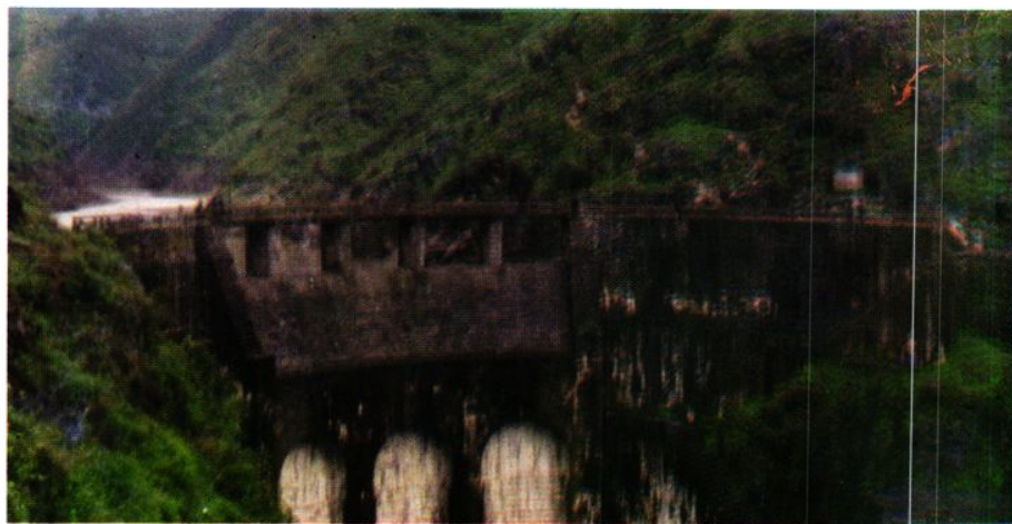
峡门口水库浆砌石单拱坝(总容量1034万立方米、坝高51米)
