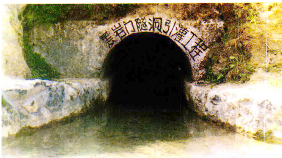
人工硬打洞长1027米，枯流0.25 秒立方米，灌田1740亩
