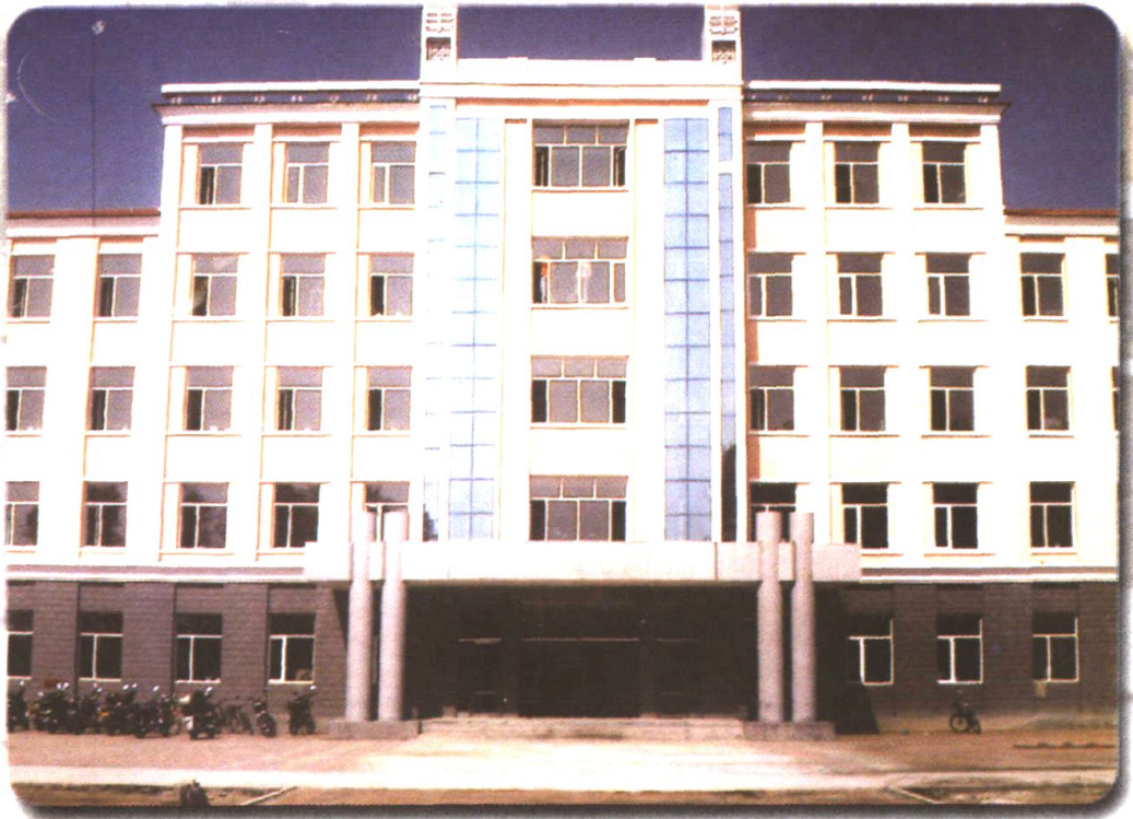
一建公司承建的二中教学楼。
