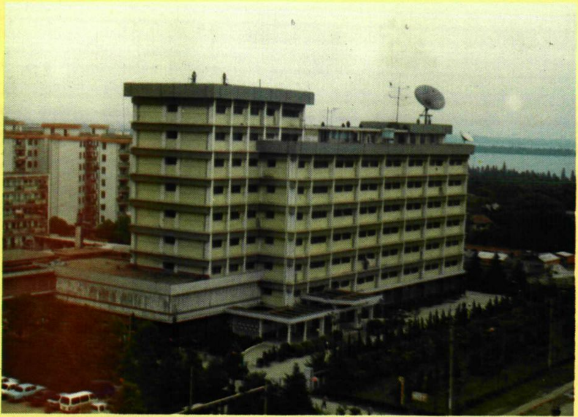
湖北省电力试验研究所试验主楼
