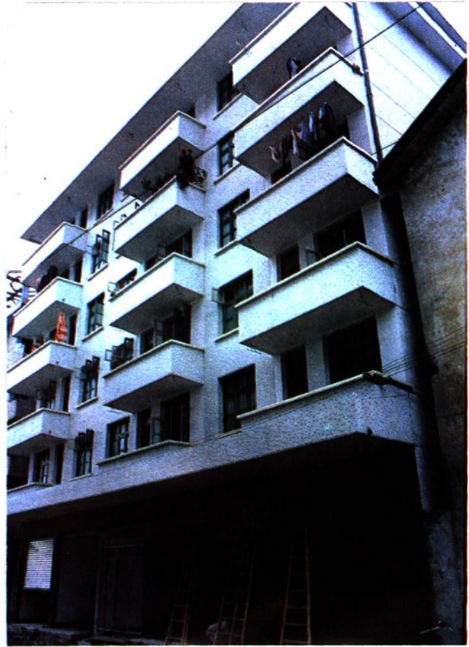
90年代县建设银行办公楼
