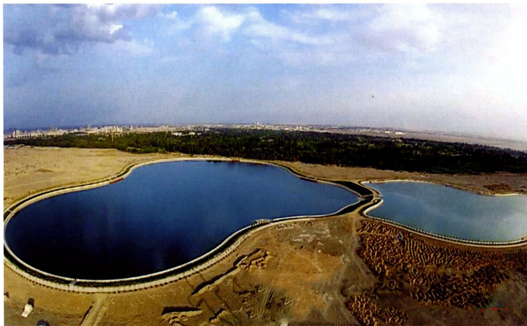
酒泉市北大河综合治理——调蓄水库
