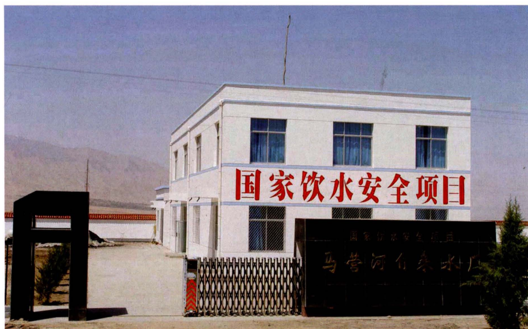
国家饮水安全项目——肃州区马营河自来水厂
