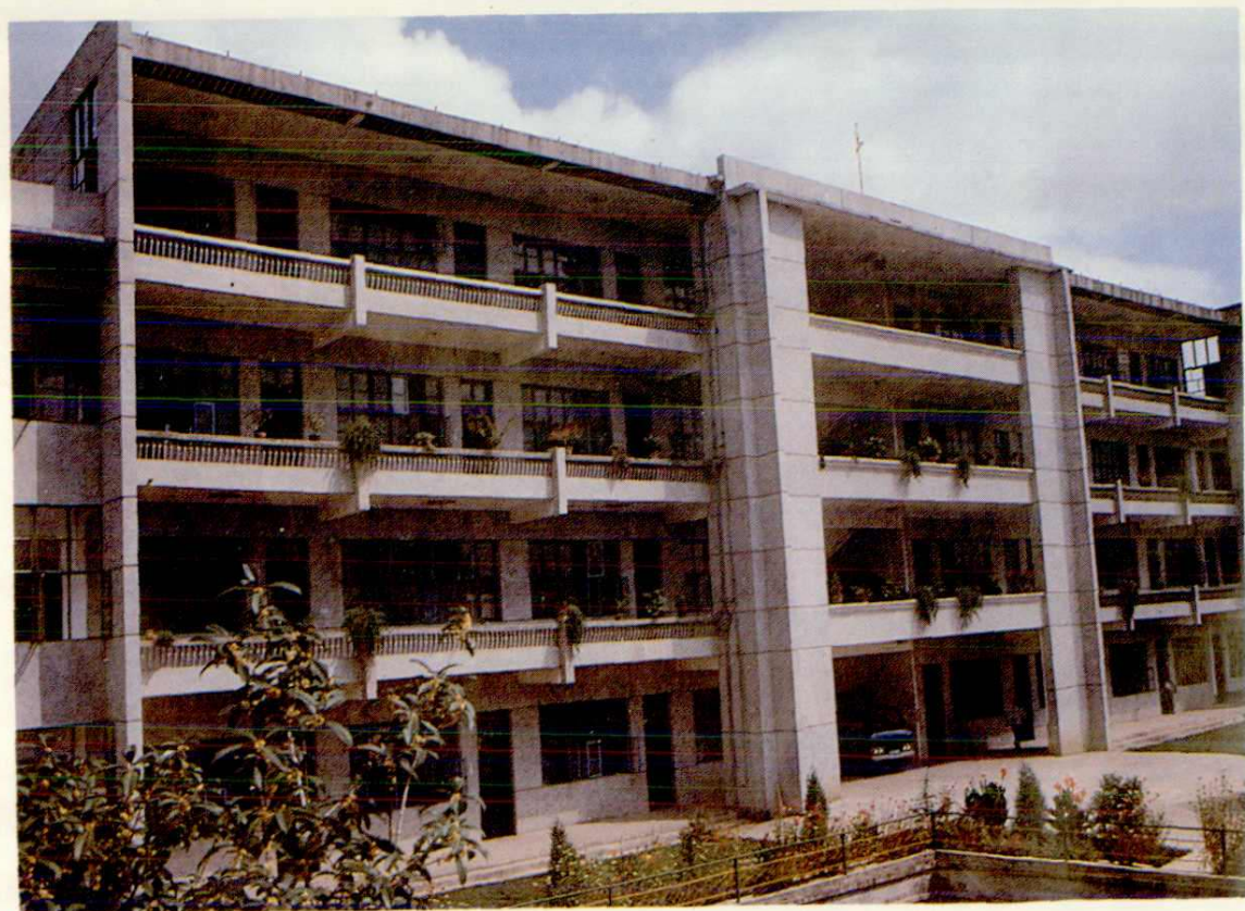
县政府办公大楼
