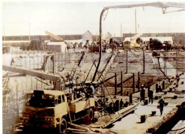
大面积混凝土浇灌和混凝土传递式泵送情景
