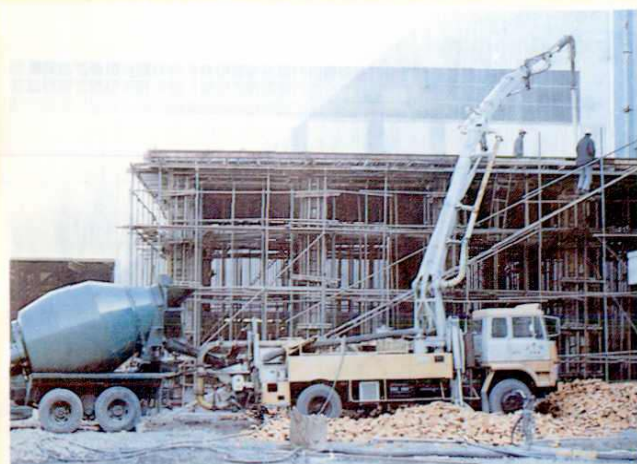
混凝土机械化浇灌
