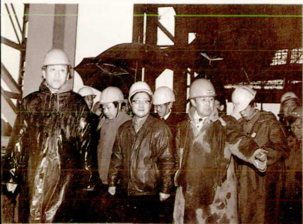
刘壮飞经理、李守顺副经理陪同原上海市副市长黄菊同志视察二十冶承建的上钢三厂中厚板工程。
