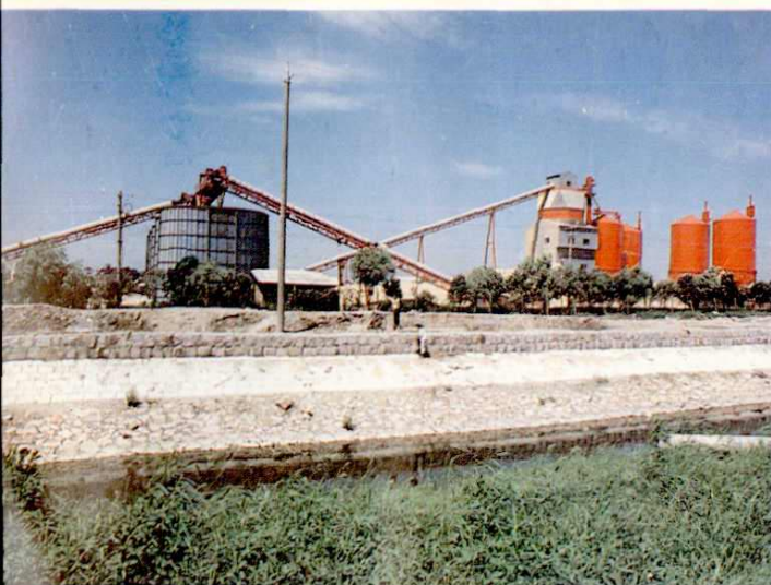
二十冶年产50万立方米混凝土的现代化搅拌站
