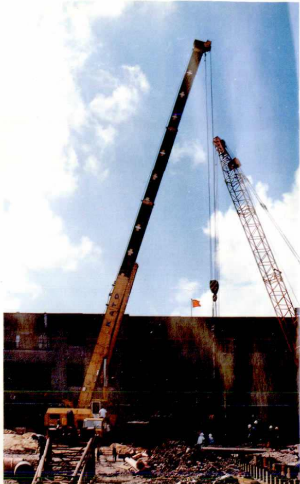
二十冶吊装运输机械在作业中
