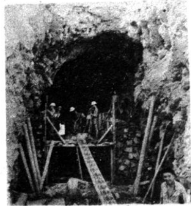
浆砌溢洪隧洞
