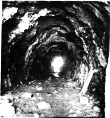
溢洪隧洞未浆砌前
