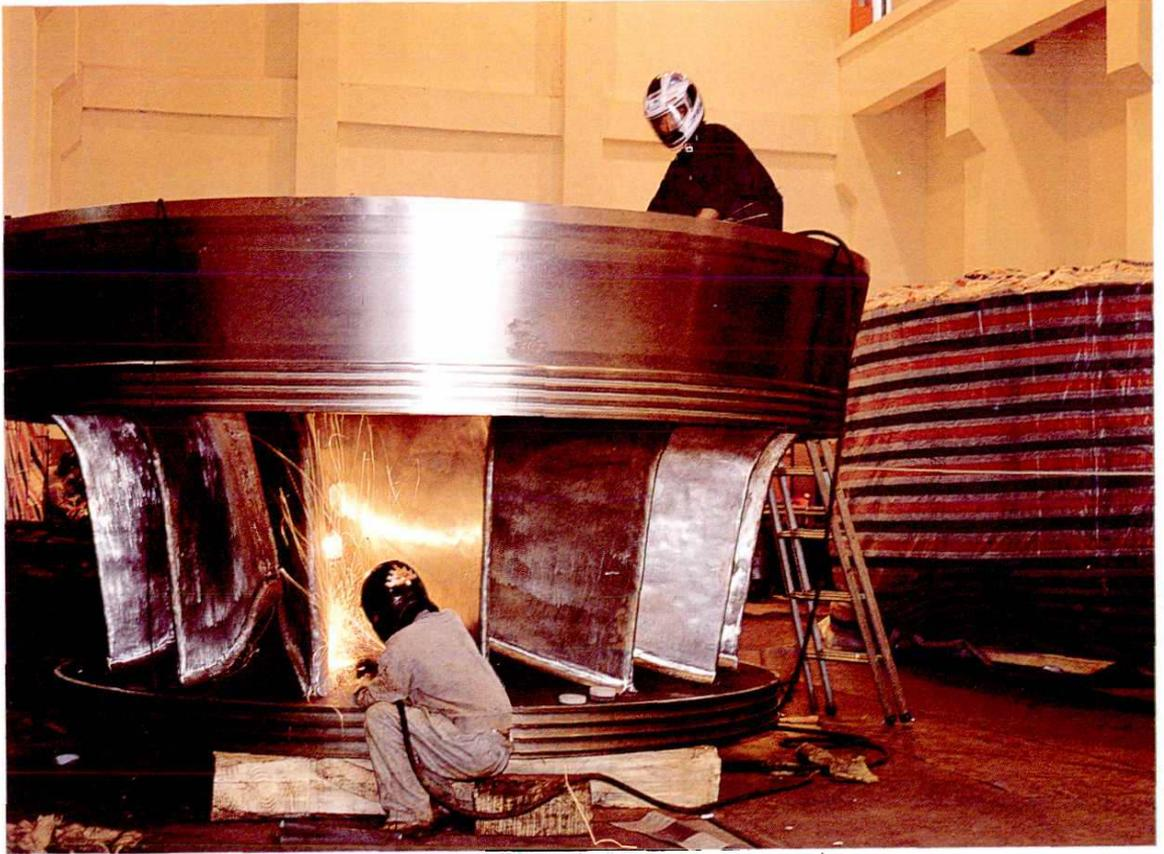
湖南镇电站职工在检修中补焊10万千瓦机组水涡轮
