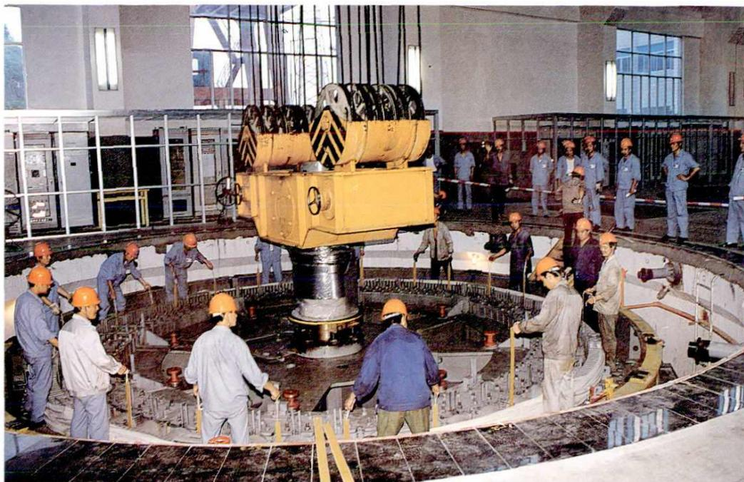
机组检修起吊转子
