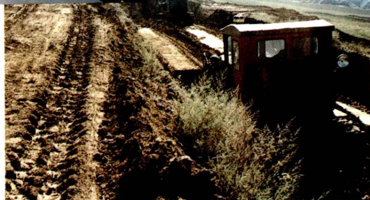
农田基本建设工地
