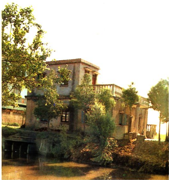
四甲电力灌溉站
