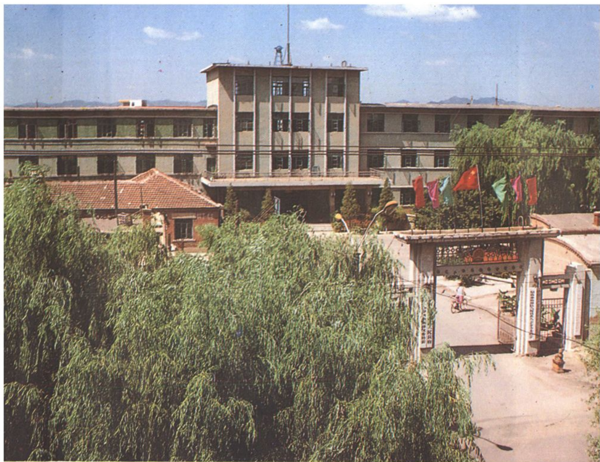
区机关办公楼
