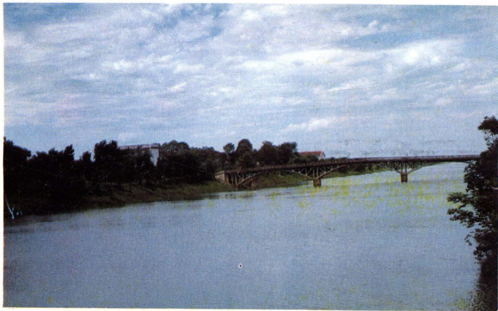
人工开挖的益阳新河
