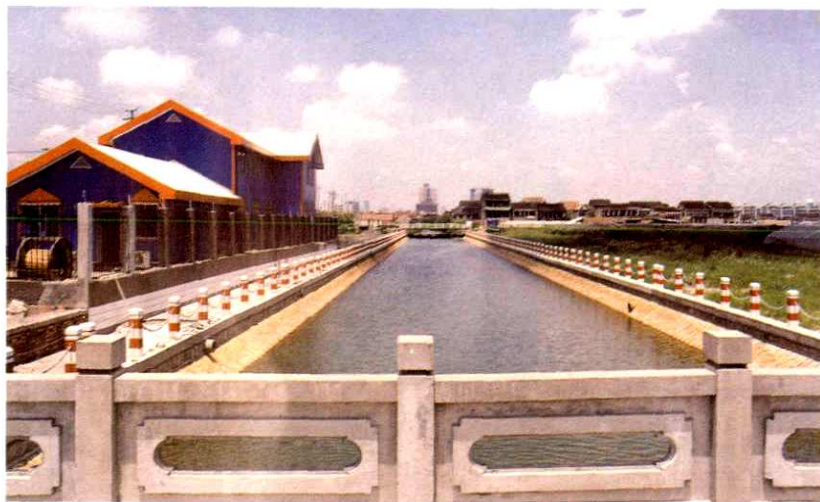
镇政府每年安排一定的财力，集中整治农村河道，建筑石驳岸，农村面貌焕然一新。左图为镇工业园区内的一条河道整治后的新貌
