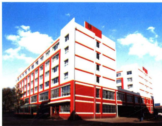
新建教学楼、学生公寓、餐厅食堂
