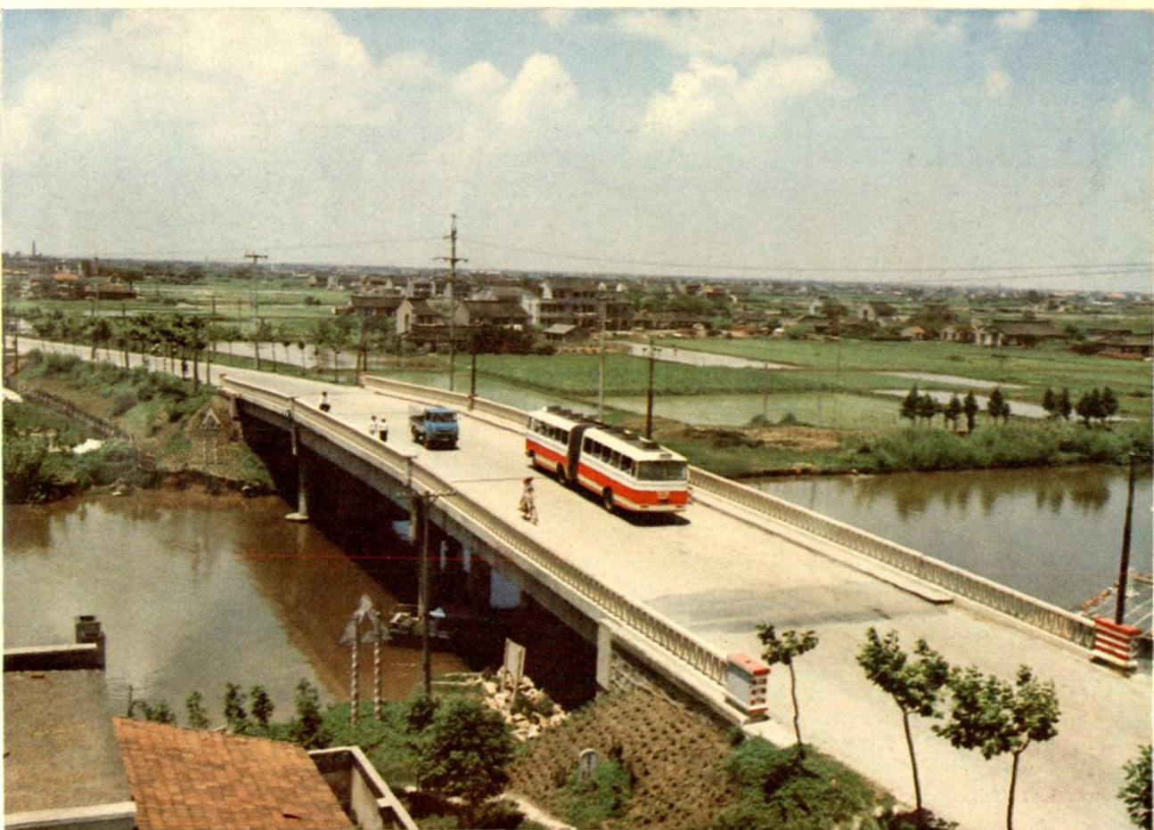
上川路川杨河大桥
