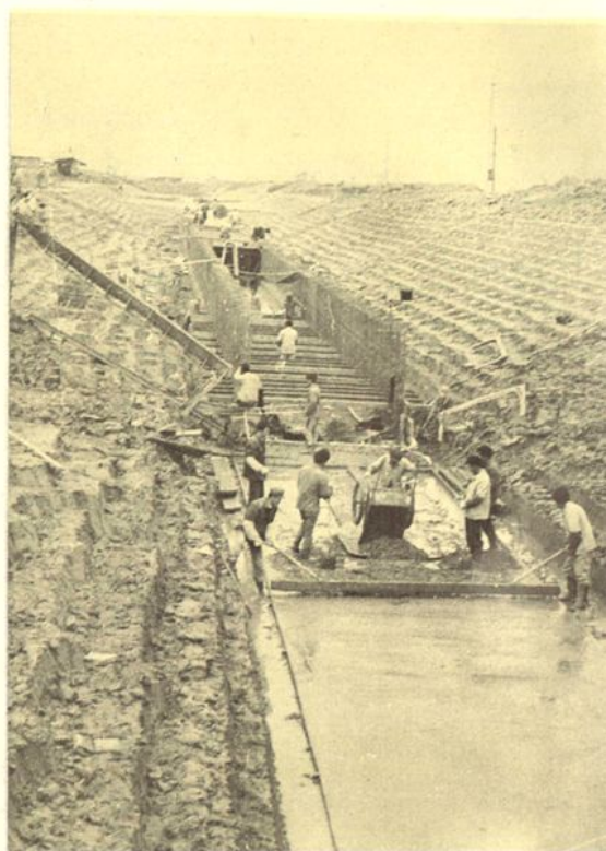
施工中的南区污水工程
