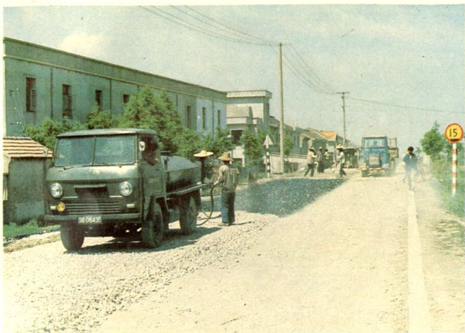
龙东路路面施工
