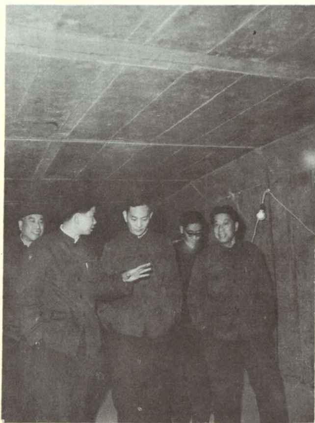
副市长倪天增和浦东工程指挥部丁文虎等 巡视南区污水工程管渠
