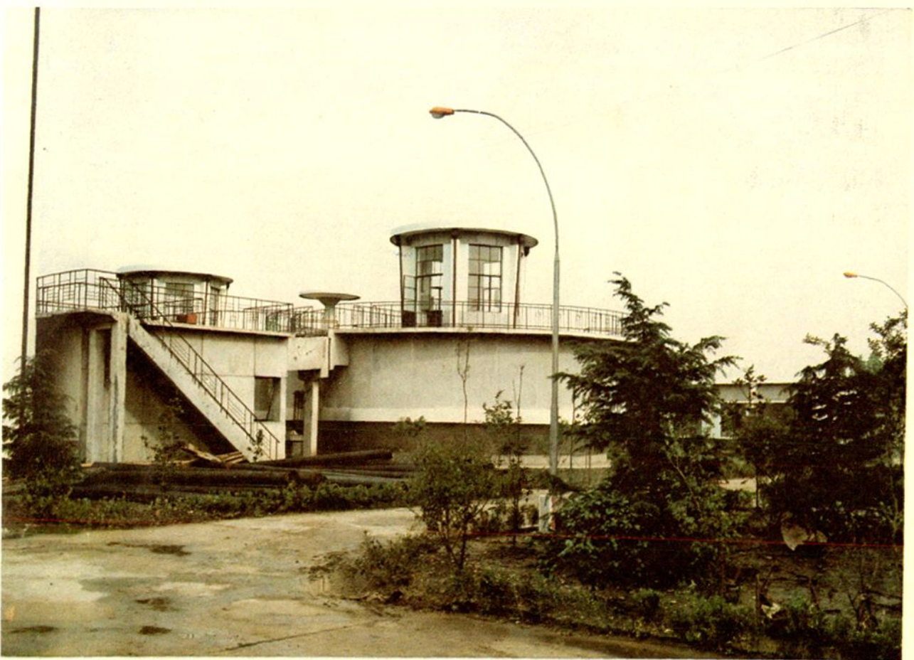
城镇自来水厂过滤池
