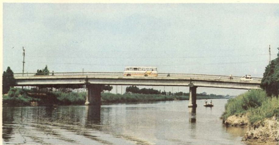
川北路川杨河大桥
