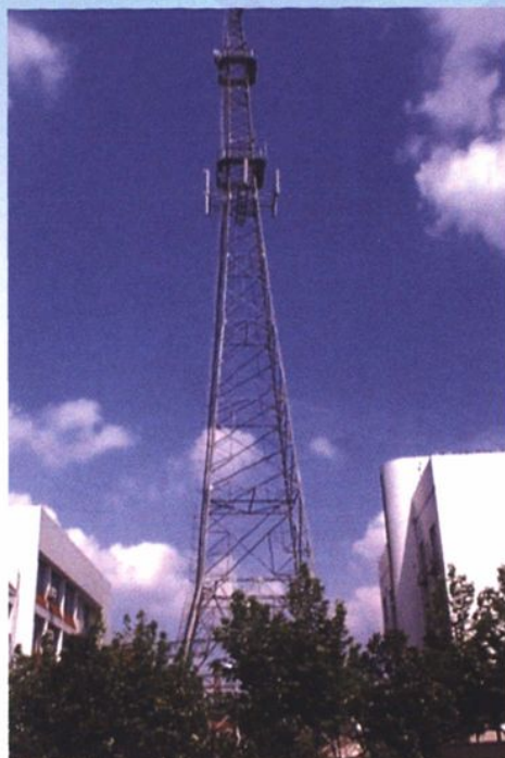
1996年，通州市供电局建成苏北第一个一点多址微波通信系统。图为83米高的全向微波塔
