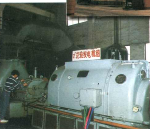
◀ 县火电厂 汽轮发电机组
