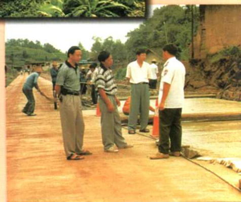
▲ 建设中的县城至泸州二级水泥公路
