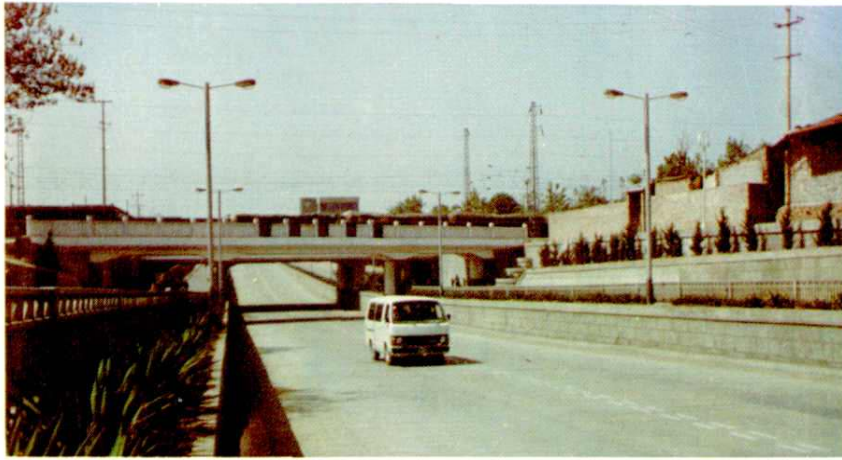
↓ 东风路立交桥
