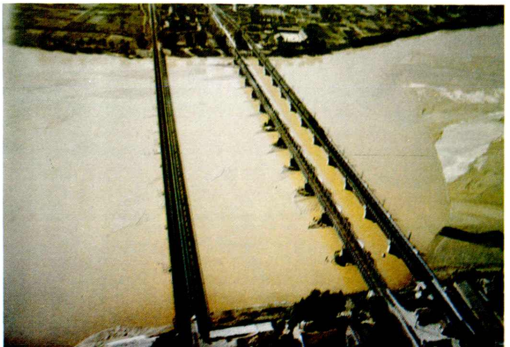
→咸铜、陇海 铁路渭河大桥
