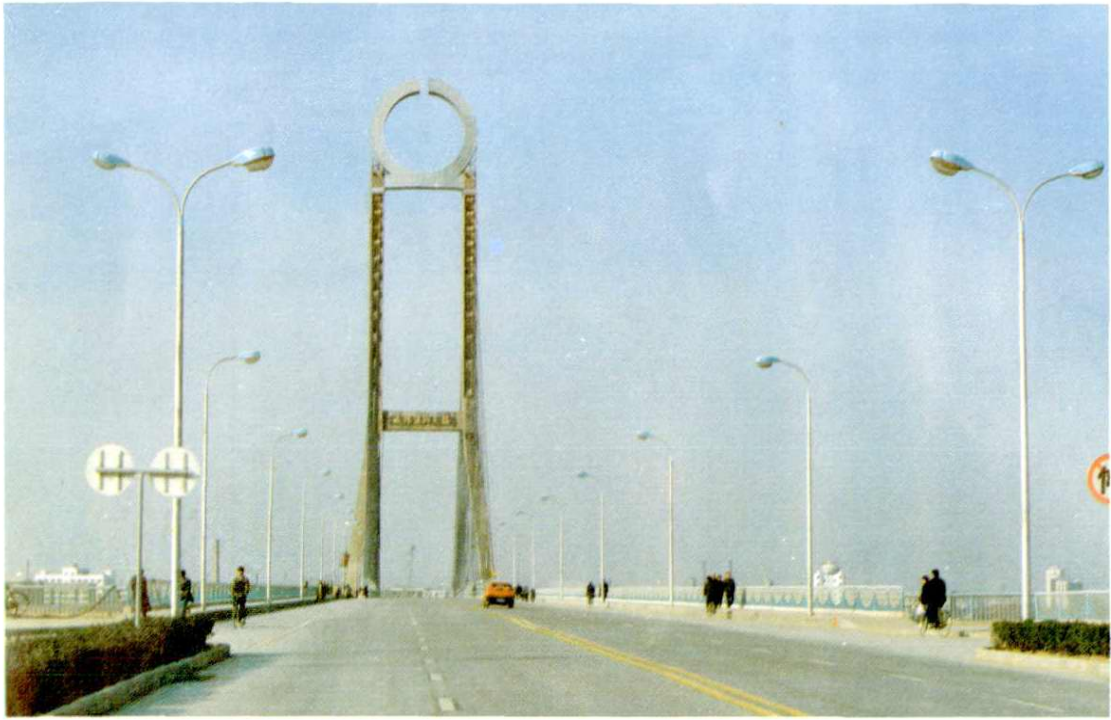
←渭河斜拉式大桥
