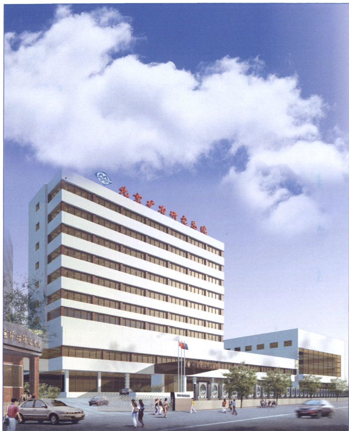
▲ 北京矿冶研究总院院部主楼
