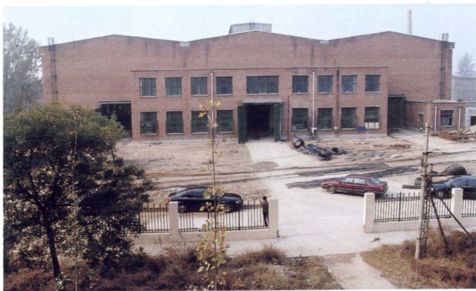
◀ 建设中的固安 产业基地
