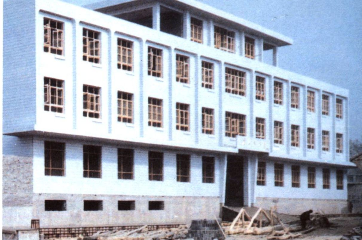
龙门村新建成的卫生所（楼上为电视插转台）
