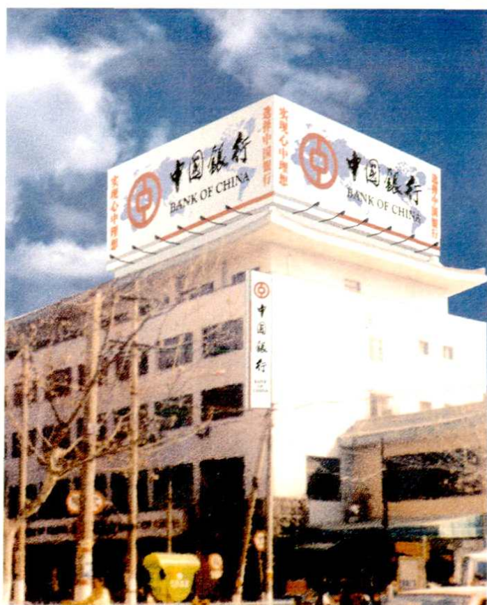
中国银行咸阳分行大楼
