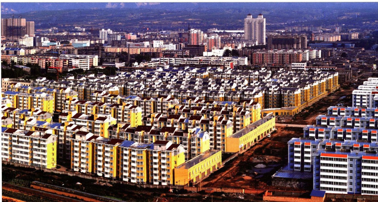
2007 年 9 月，山西焦煤汾西矿业棚户区改造工程竣工
