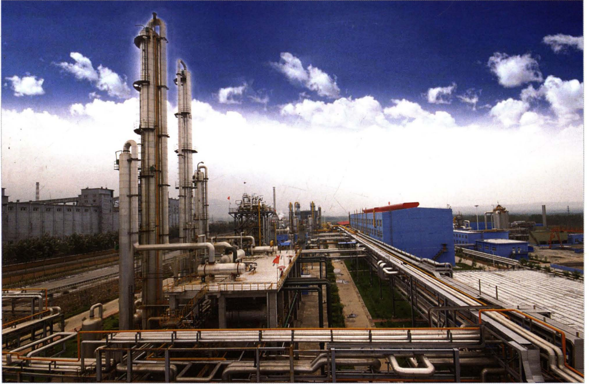
2009 年，山西焦化 20 万吨 / 年焦炉煤气制甲醇项目投产，是国内第一家以焦炉煤气配入水煤气生产甲醇的项目
