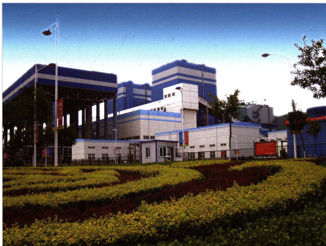
2012 年 12 月，古交电厂总装机容量达到 1800 兆瓦，是全国最大的燃用洗中煤坑口电厂
