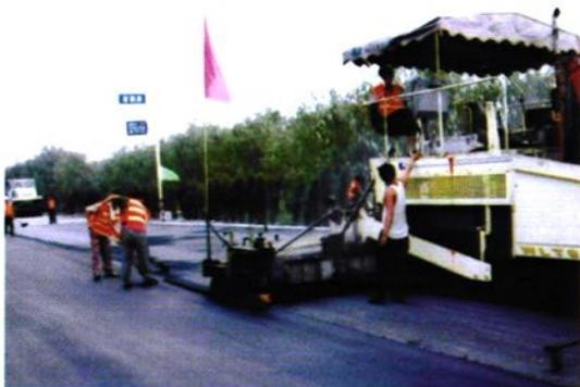
省道台忻线沥青混凝土路面施工
