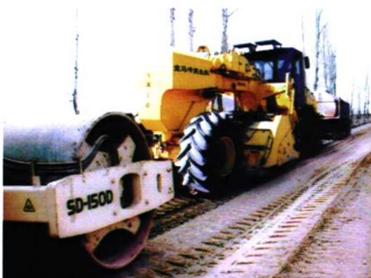
采用冷再生技术进行地面施工
