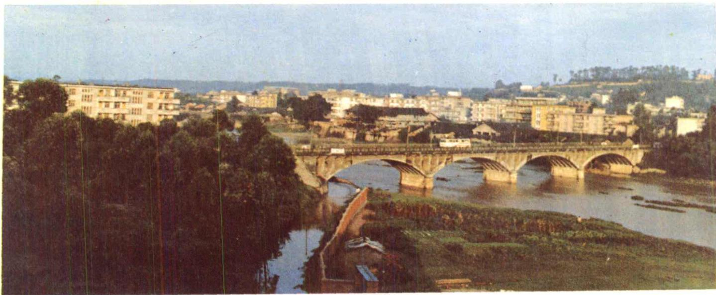
浦江新东门大桥（双曲拱、钢筋混凝土）
