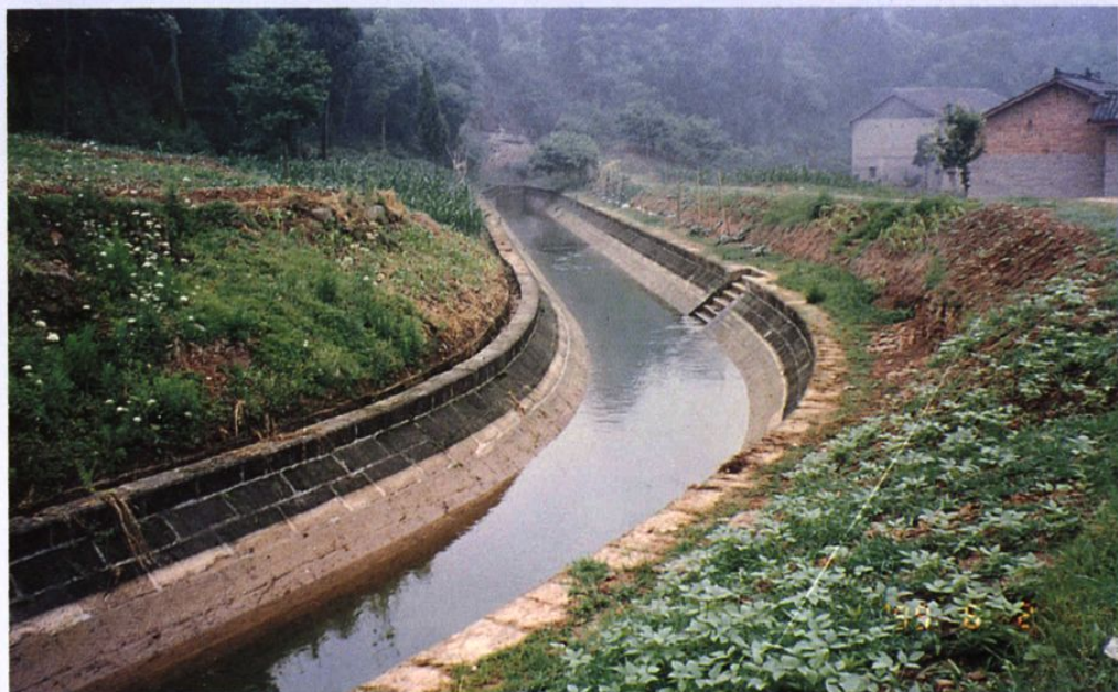
左分干渠明渠段
