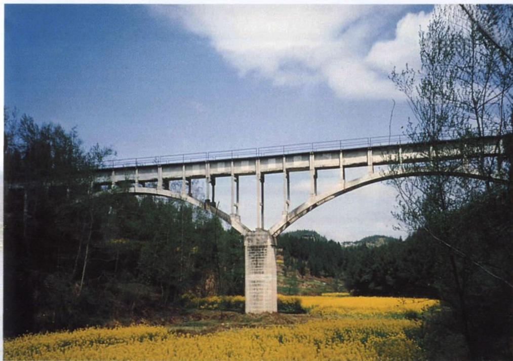
定水分支渠跳蹬河渡槽
