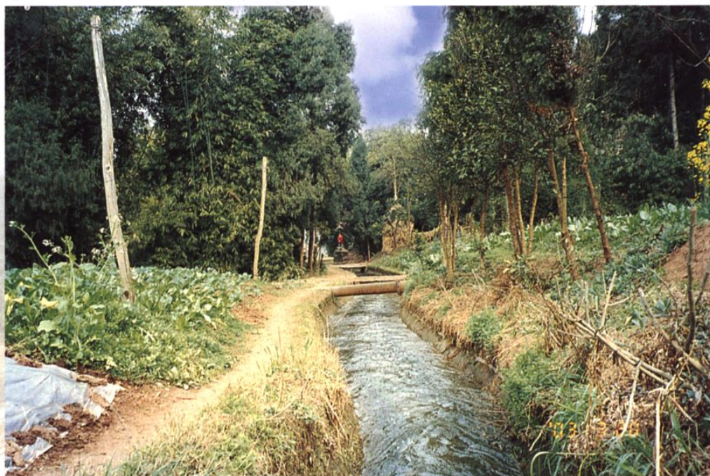
青土垭农渠明渠段
