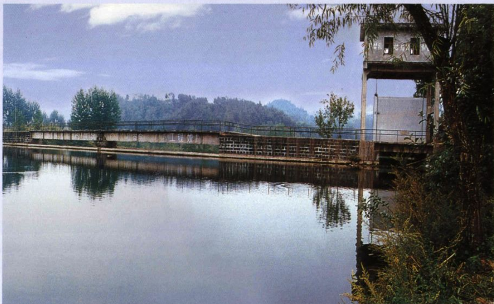
右总干渠王大湾过水库
