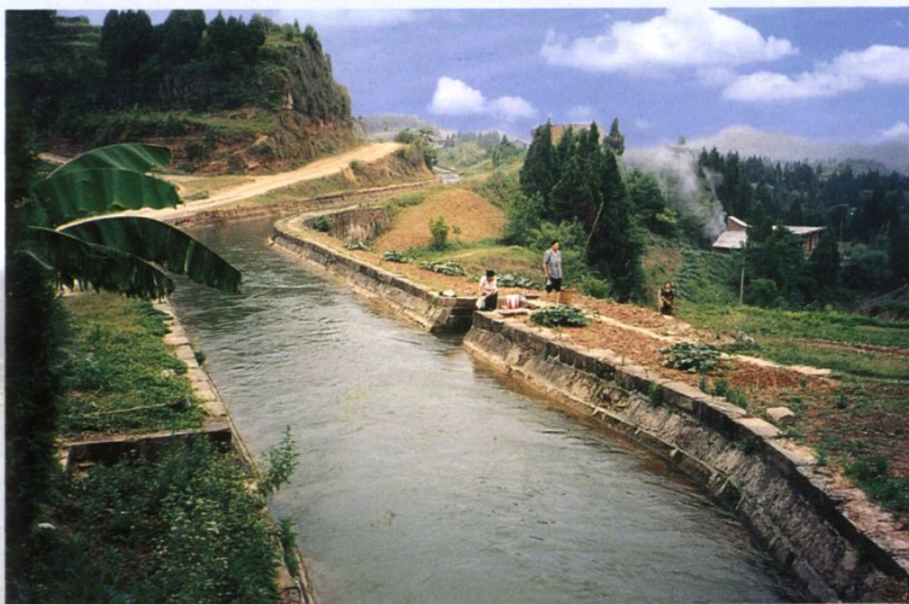
西莲分干渠明渠段
