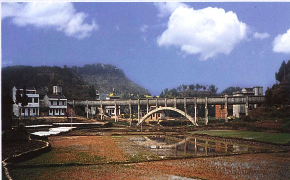
西蓬分干渠张家坝渡槽
