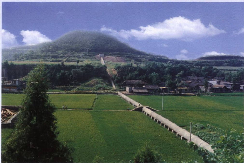
石河分支渠盘龙倒虹管
