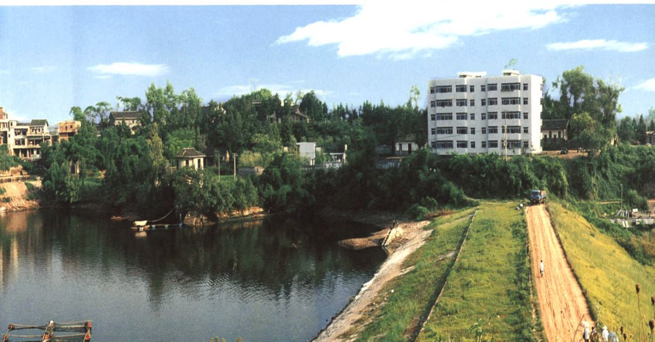
西蓬分干渠冲国蓄工程八尔滩水库
