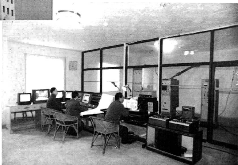
广播电视同塔反射机房
