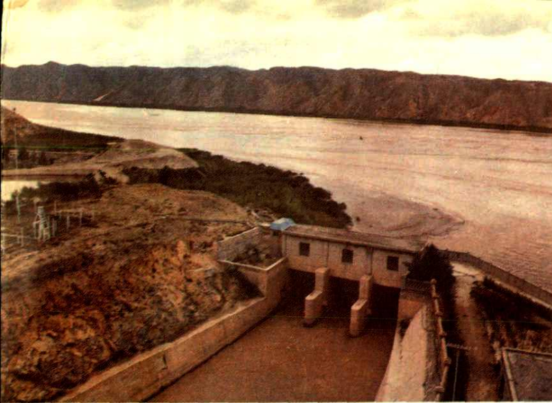
一九七〇年修建的东干渠
