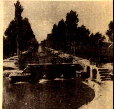
农场渠分水闸
