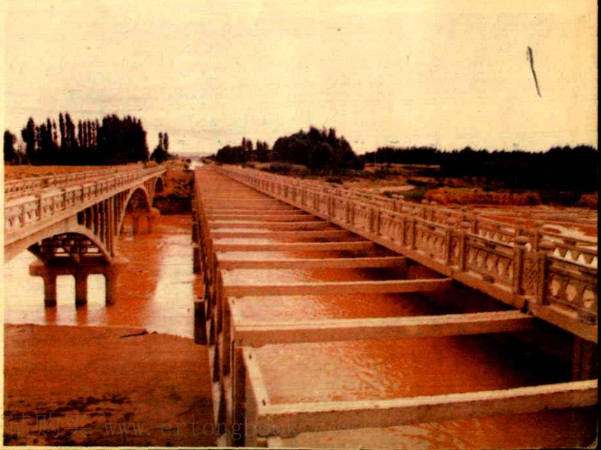
东干渠山水沟渡槽
