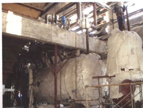
2005年12月，通辽热电公司建设中的75吨锅炉
