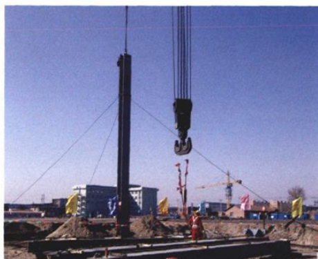
吊装炉钢架
