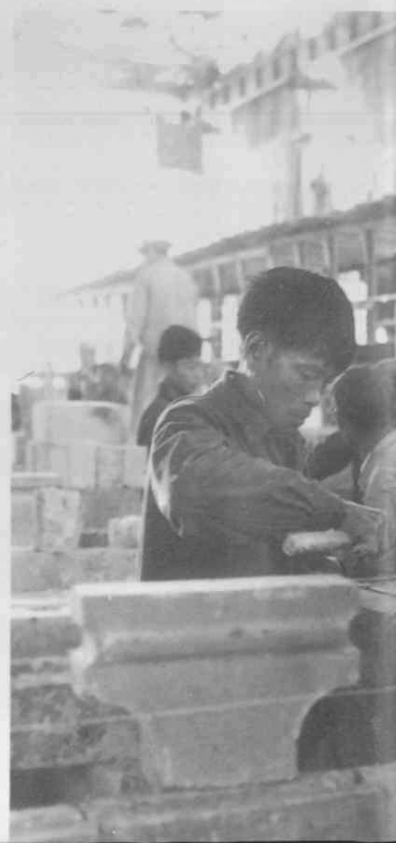
开展现场对口施工
