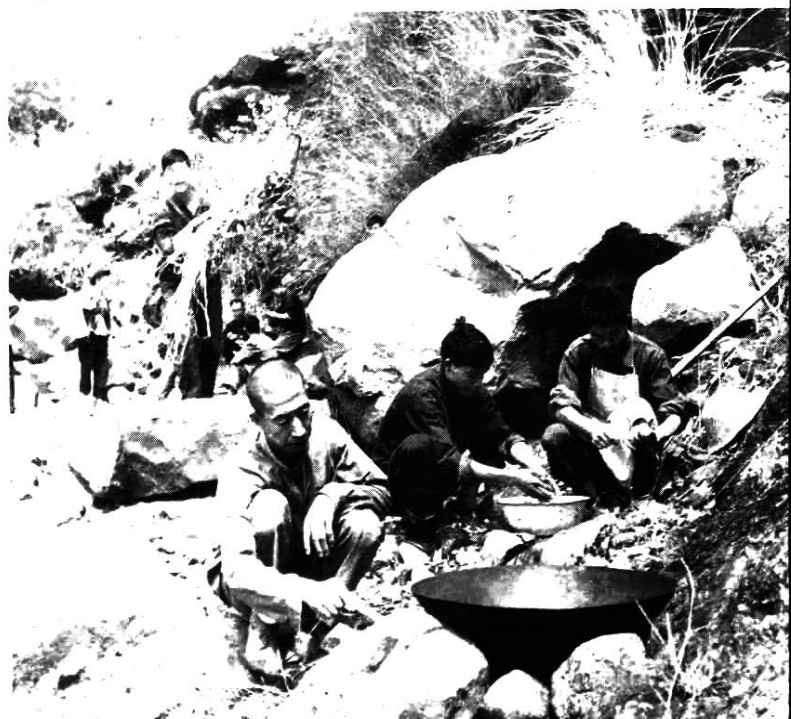
三块石头架口锅的工地食堂
