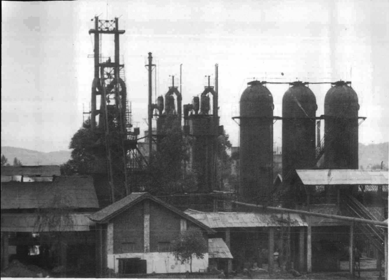
四一〇厂28立方米试验小高炉冶炼攀枝花高钛型钒钛磁铁矿
