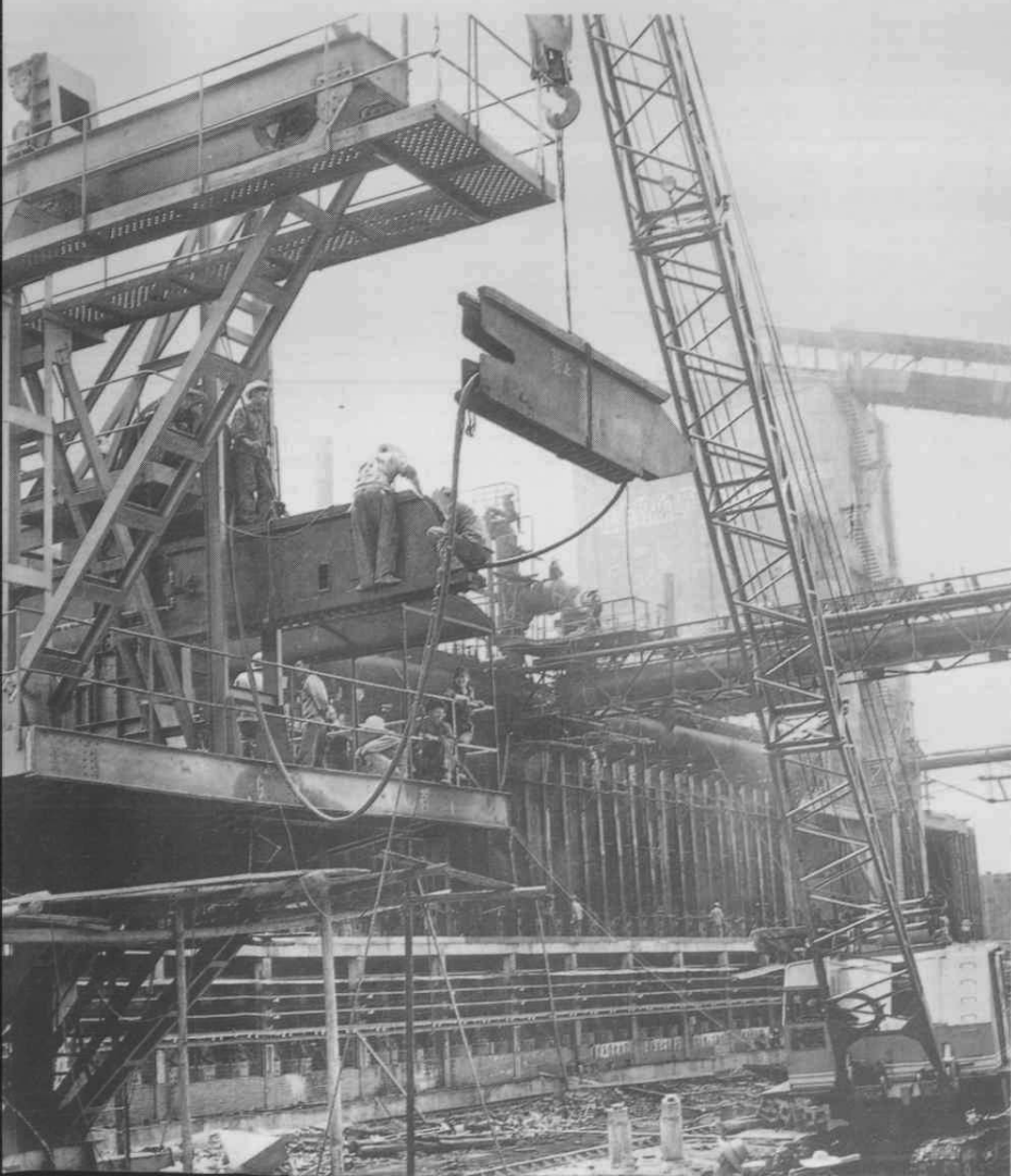
建设中的焦化厂一号焦炉
