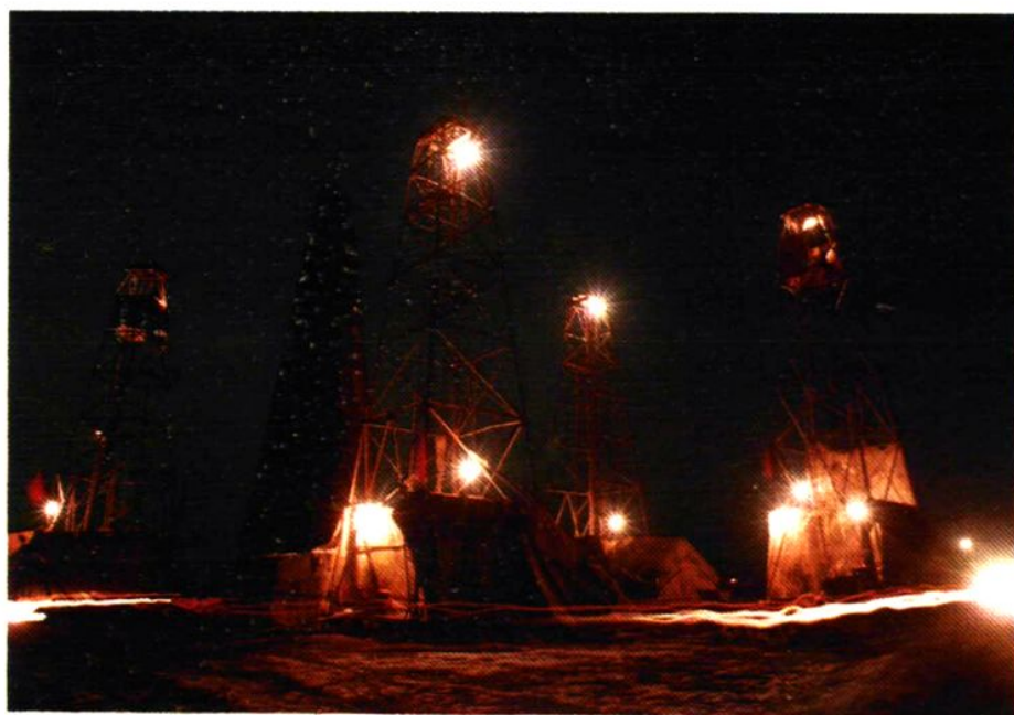
注浆堵水工地夜景
