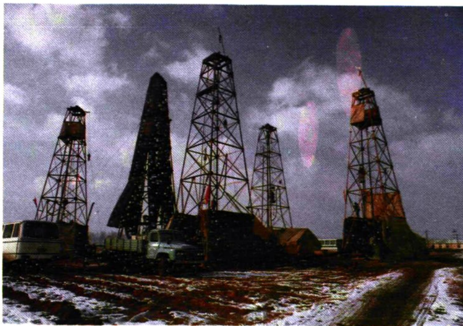
注浆堵水工地
