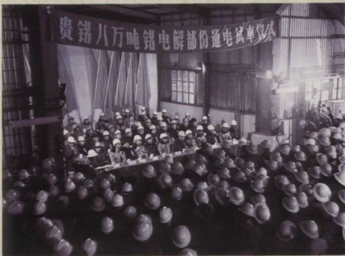
1981年12月18日， 贵州铝厂引进的8万吨 电解铝工程首批电解槽 通电投产
