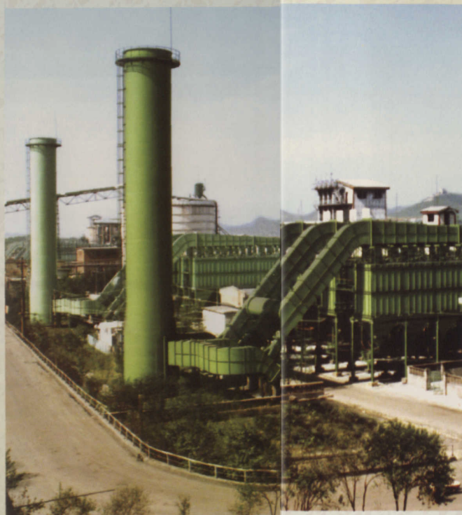
贵州铝厂电解铝厂干法净化系统
