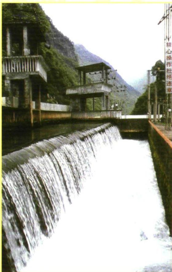
20世纪建成的野三河一级电站，装机 $2 \times 1600$ 千瓦+ $1 \times 1580$ 千瓦，是建始县电网的骨干电源点之一，长期担任县电网的调频任务。
