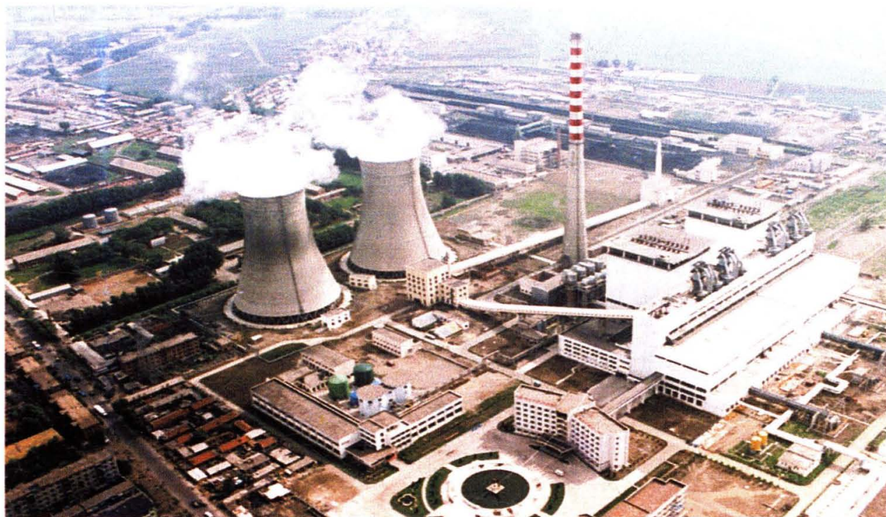
创全国国产机组第一个一流火电厂——长春热电二厂
