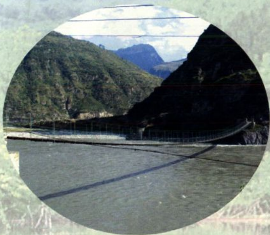
宰羊至永和吊桥
