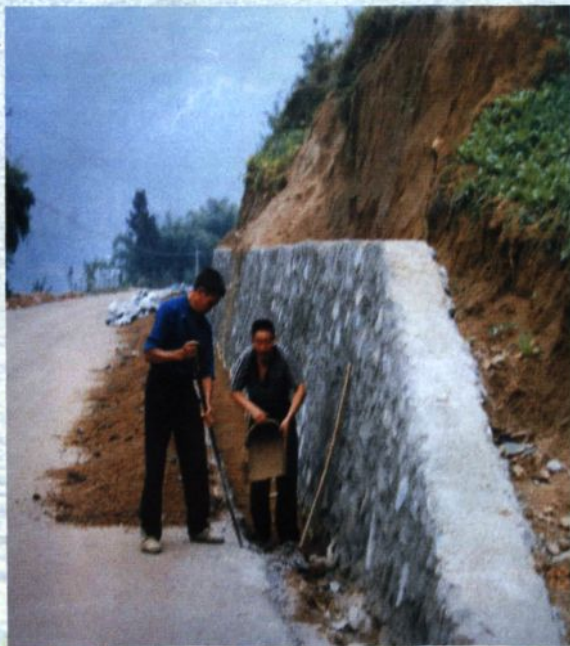
正在建设中的先新路
