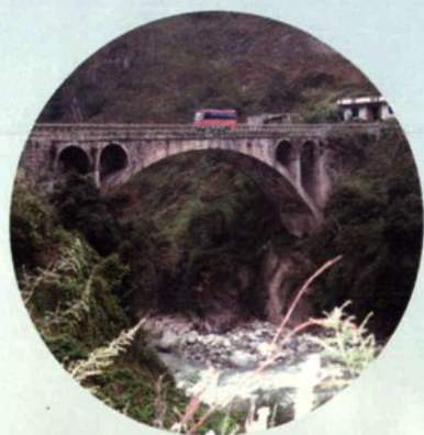
108国道公益大桥
