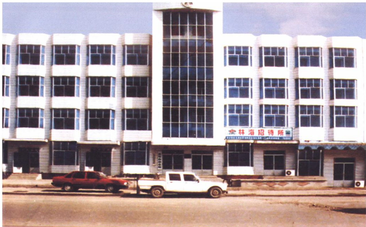
林业局办公楼
